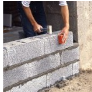
Réalisation de murets en BBM (Blocs Béton Manufacturés)
