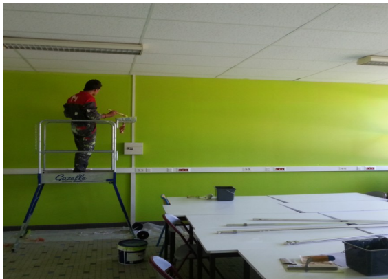
Mise en peinture de salles
